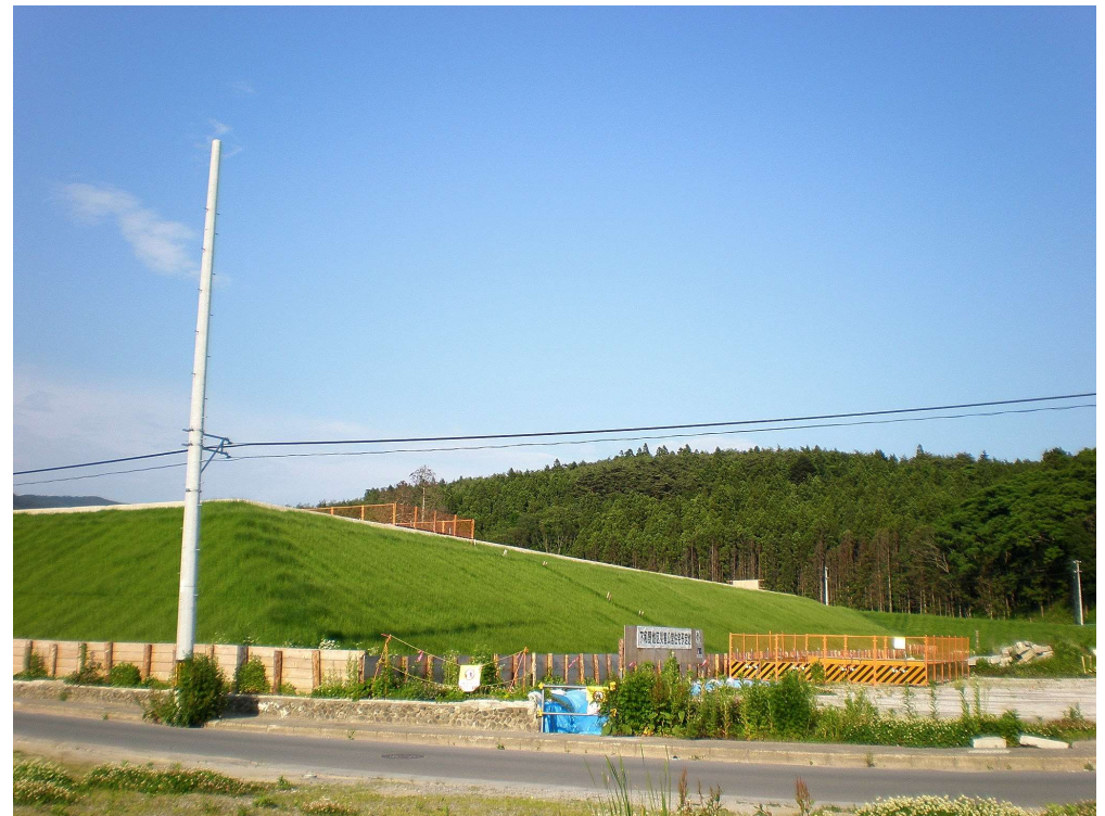
ハリシバモック災害公営住宅②.JPG
