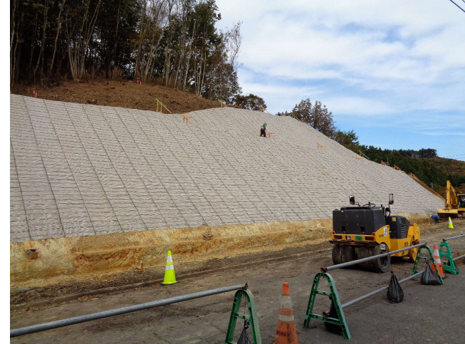
森樹郎マツ・一戸山形線外川地区道路災害復旧.JPG
