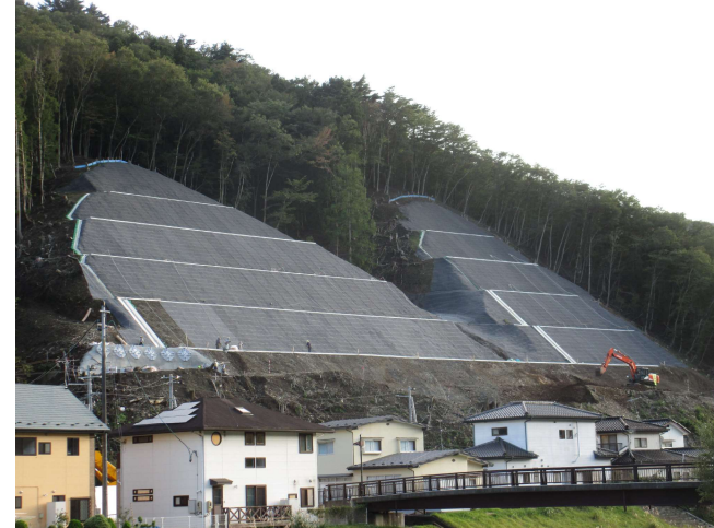
ドレーンシート・釜石西道路.JPG
