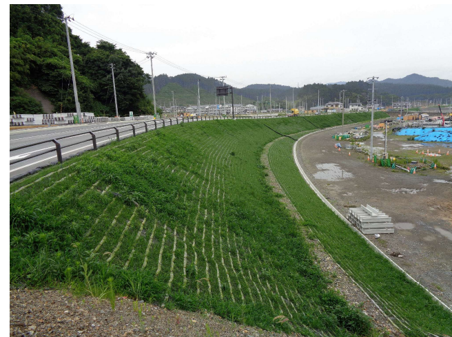
カンガルーマット・国道340号今泉地区道路改良舗装工事.JPG
