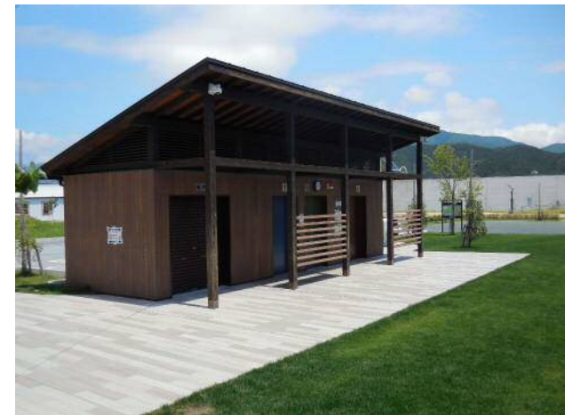
トイレ・大船渡市・夢海公園.JPG
