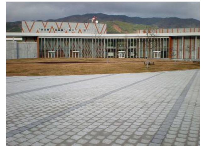
インターロッキング・陸前高田コミュニティセンター.JPG
