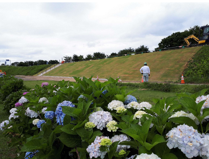
キョーリョッカー・北上川上流盛岡地区河川維持工事.jpg
