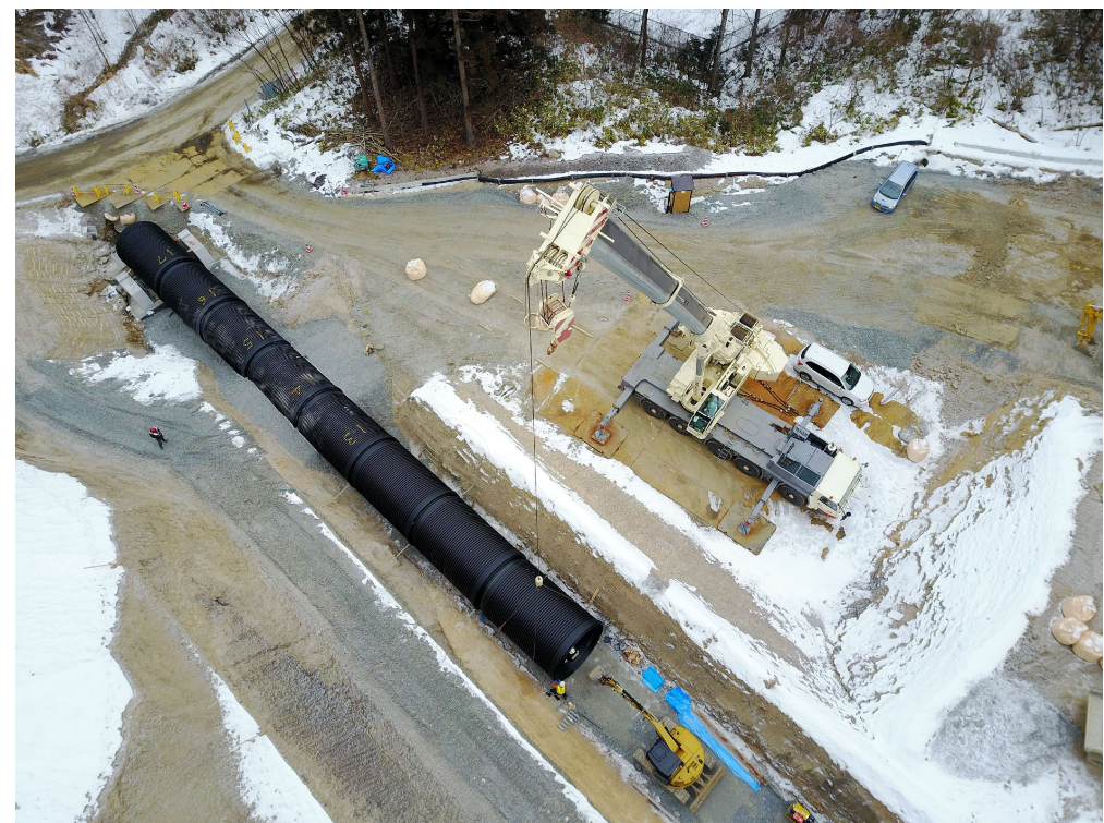
4ハ威尔管施工 釜石道.JPG
