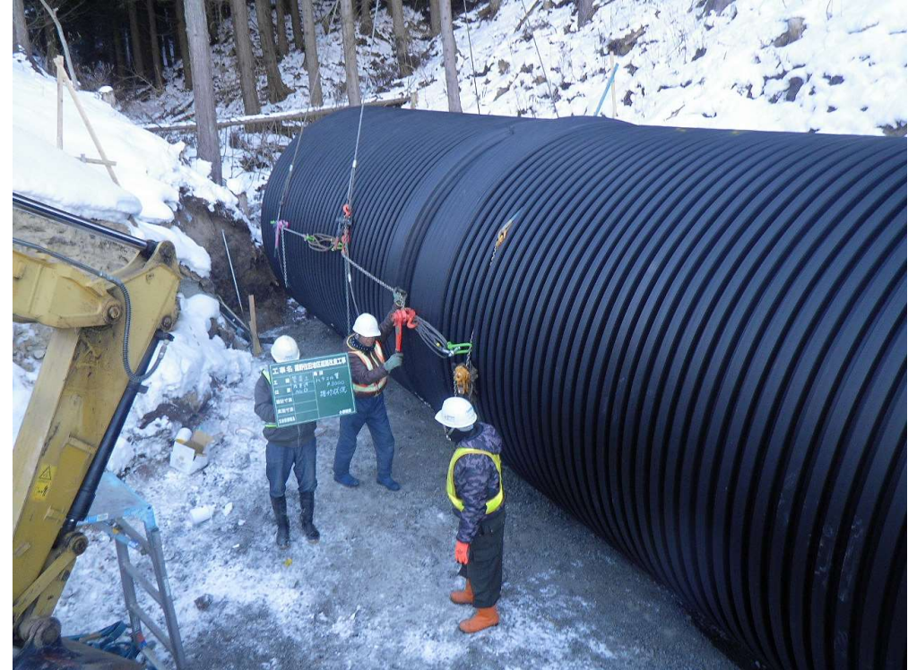
2ハ威尔管施工 釜石道.JPG
