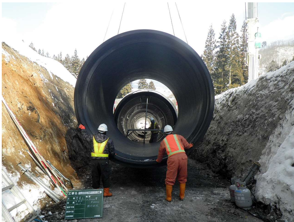
3ハ威尔管施工 釜石道.JPG
