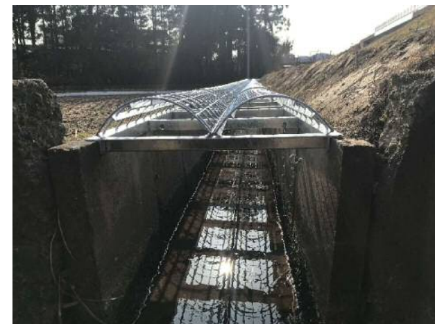
用水路転落抑止「オチナイデ」花巻地区設置後②.jpg
