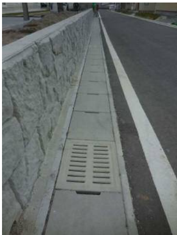
コンクリート集水蓋(ファイコン)陸前高田市市区画整理①.JPG
