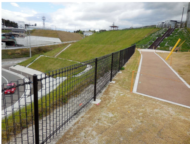
転落防止柵兼用フェンス・高田区画整理.JPG
