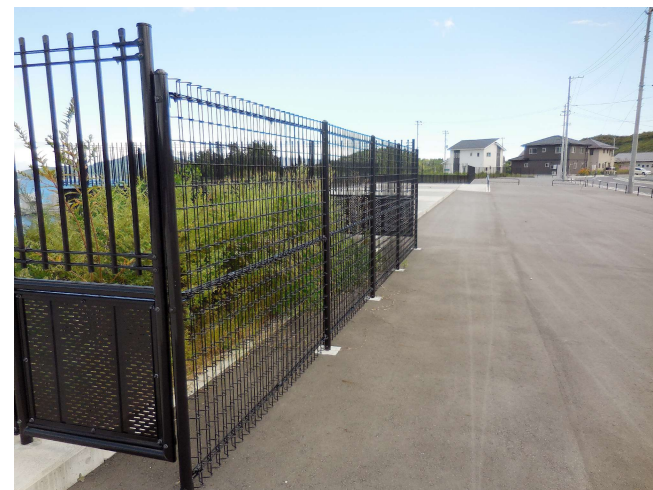
転落防止兼用フェンス.JPG
