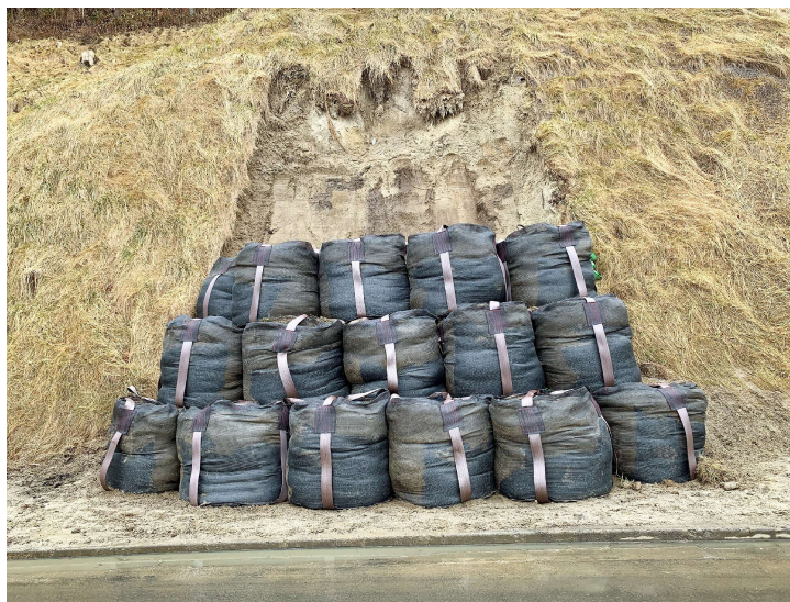
大型植生土のう・陸前高田市道.JPG
